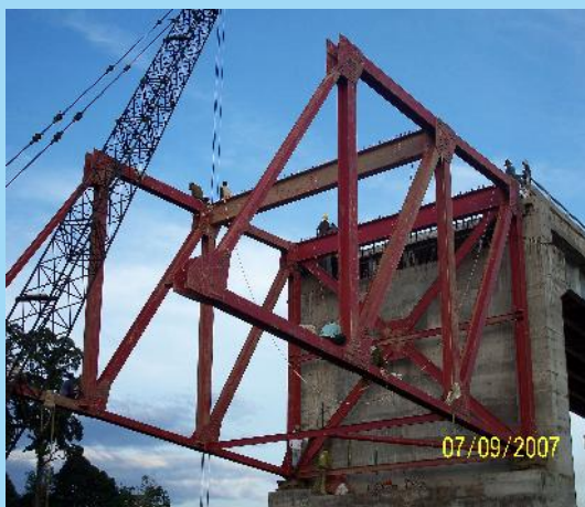
Pemasangan Bentang 60 M
