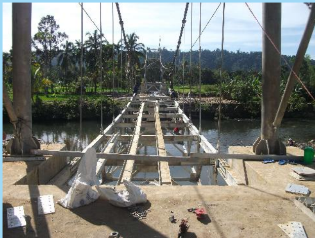
Pemasangan Jembatan Gantung 75 M
