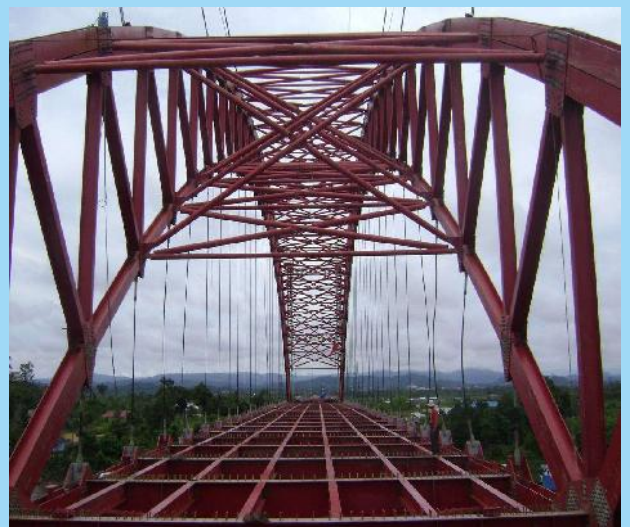
Pemasangan Bentang 150 M
