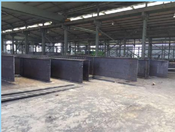
Pabrikasi Bentang 40 M
