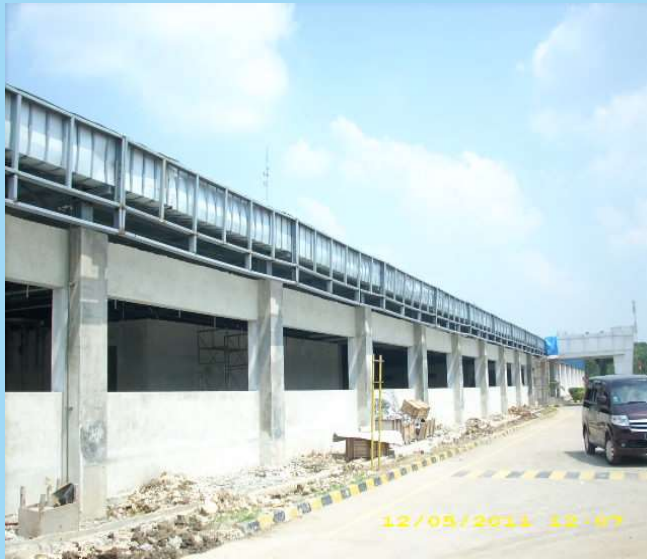
Gudang PT Minda Automotive Asean KIIC-Karawang Lokasi : Karawang - Jawa Barat Item Pekerjaan : Pabrikasi dan Pemasangan
