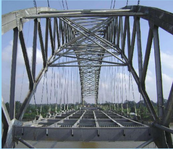
Pemasangan Bentang 150 M
