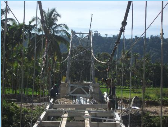
Pemasangan Jembatan Gantung 75 Meter
