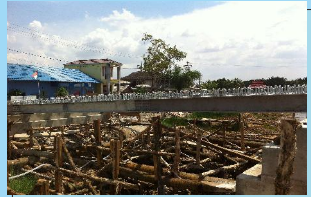
Jembatan Girder Bentang 12 M Marabahan - Kalimantan Selatan
