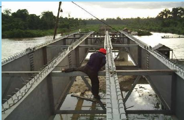
Jembatan Girder Baja Bentang 30 M - Kalteng
