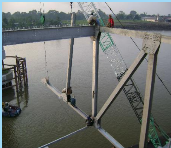
Pemasangan Bentang 60 M
