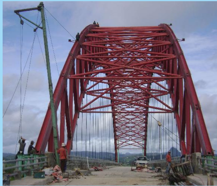
Pemasangan Bentang 150 M
