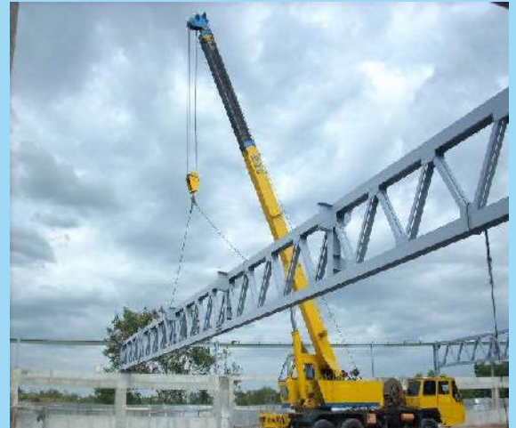
Pemasangan Rangka Baja
