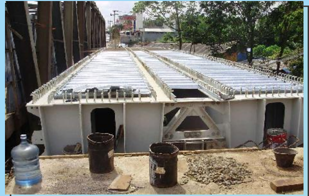
Jembatan Box Girder Bentang 45 M Cikeas - Jawa Barat
