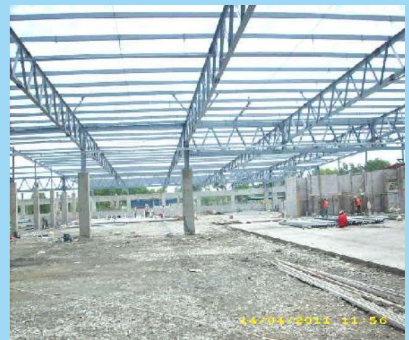
Pemasangan Rangka Baja
