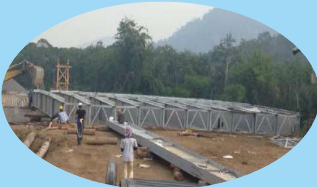
Pemasangan Bentang 25 M
