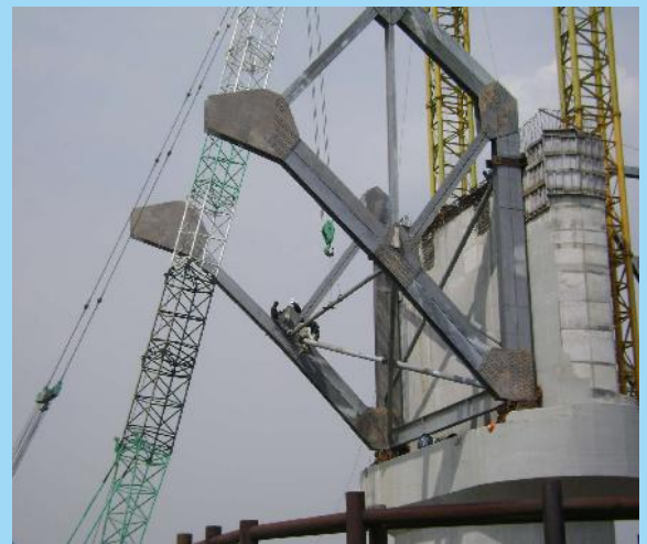
Pemasangan Bentang 150 M
