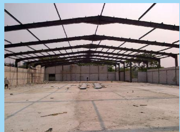
Pemasangan Rangka Baja
