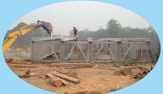
Pemasangan Bentang 25 M
