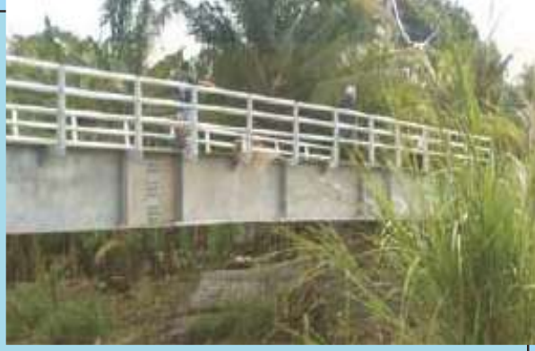
Jembatan Girder Bentang 30 M Muara Gembong - Bekasi
