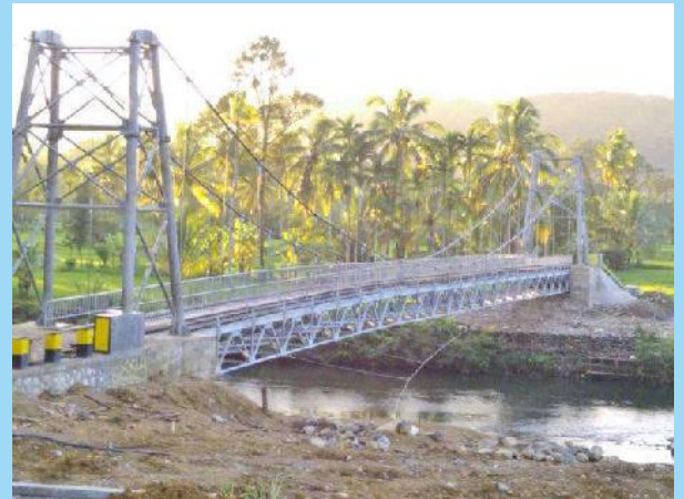
Pemasangan Jembatan Gantung 75 Meter
