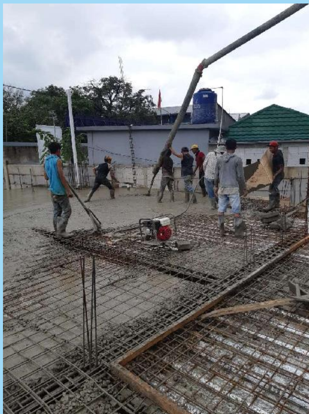
PENGECORAN LANTAI 3 MASJID AL - IKHLAS
