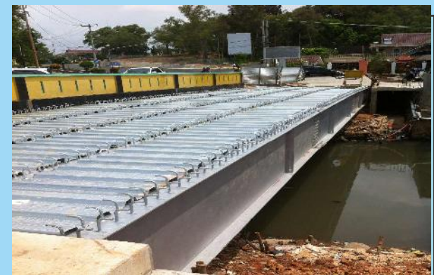
Jembatan Girder Baja Bentang 30 M - Tanjung Pinang
